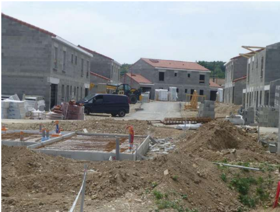
Opération d'ensemble, Est du bourg (Planil) UC au PLU (UC au POS) en cours de construction 2014
