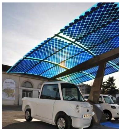
« ombrières » photovoltaïques sur un parking
