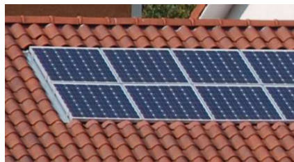
Exemple de panneaux solaires photovoltaïques
