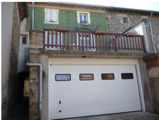
exemple de balcon avec un dessin inapproprié à l'architecture...
