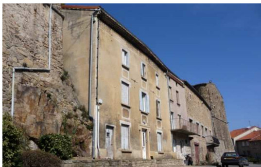
façade couverte d'un enduit texturé formant décor...
