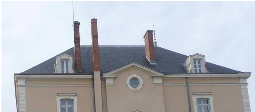
couverture en ardoise...
