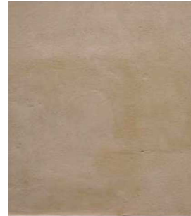
enduit lissé à la truelle
