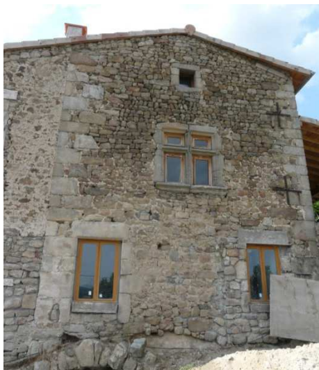
les menuiseries doivent être adaptées à la forme et à la typologie de chaque baie...
