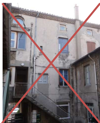
exemple d'une façade déstructurée
