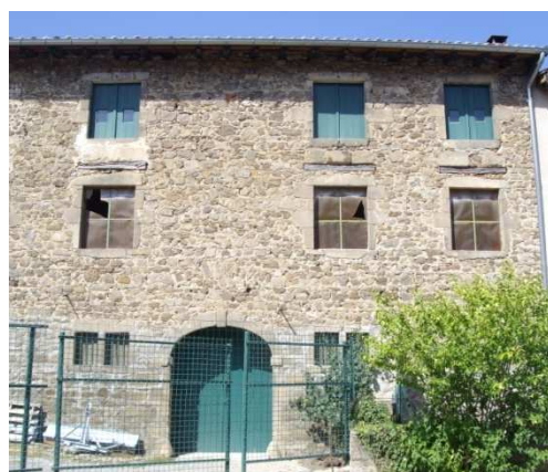
exemple d'une façade composée
