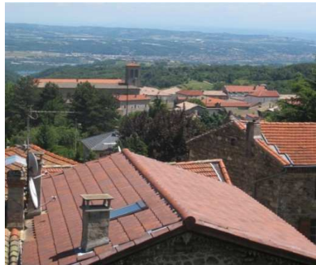
couverture en tuile mécanique
