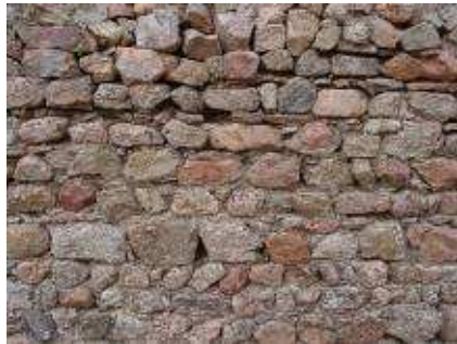
maçonnerie en pierres à bâtir destinée à être enduite...
