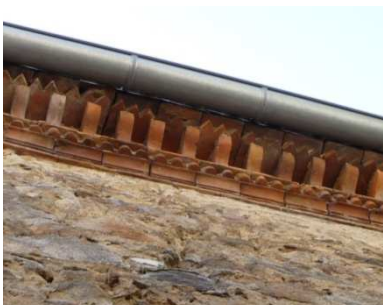
Différentes typologie de dépassées de toiture : en bois avec chevrons apparents, en pierre de taille (très rare) ou plus couramment en brique...
