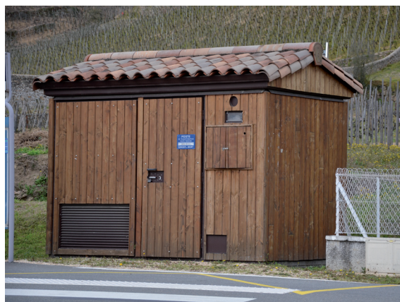
Exemple de local pour transformateur électrique
