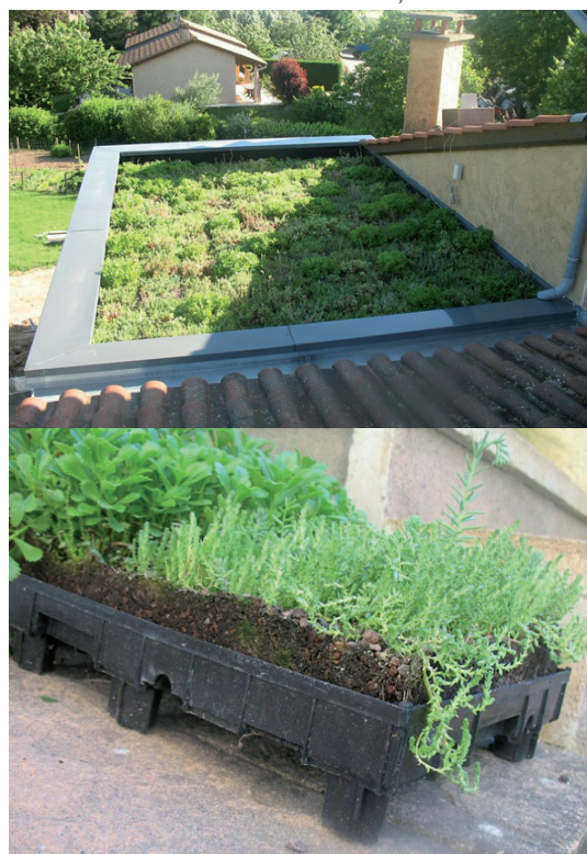
Exemple de toiture-terrasse végétalisée en bacs pré-cultivés
