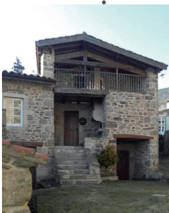
Exemple de débord de toiture
